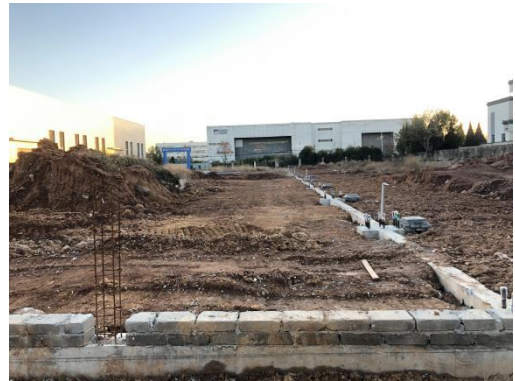
图 1-3 正在施工的厂房 B
