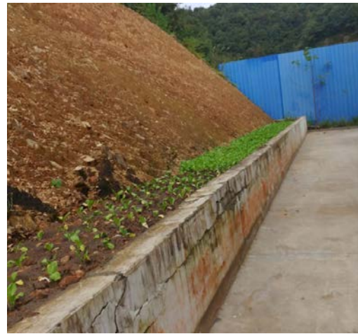
图 2-5 项目边坡现状
