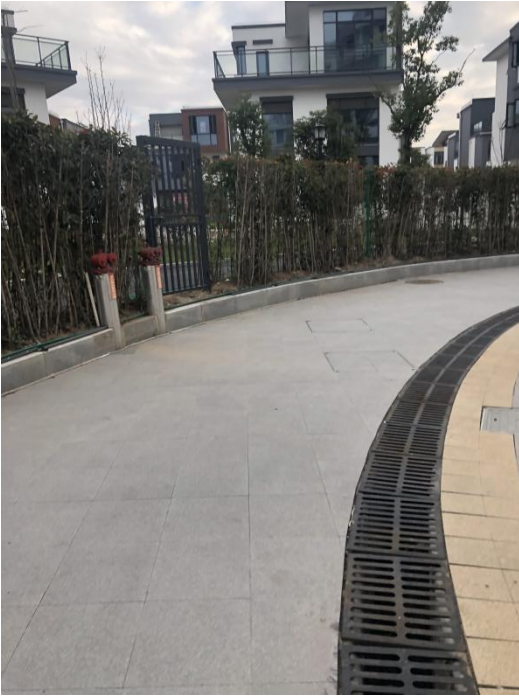
图 4-1 项目道路雨水篦子
